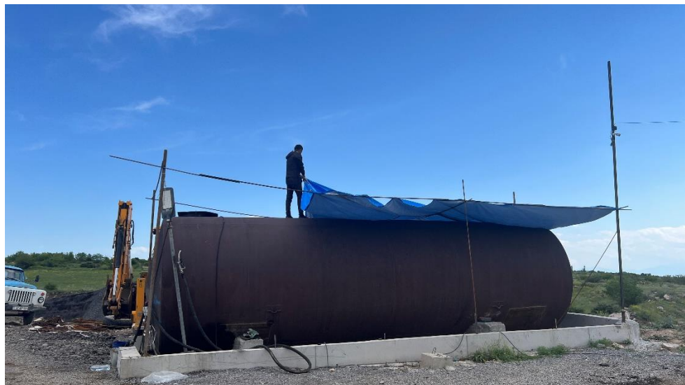
Նկար 2. Առաջադրանք 1-ի վառելիքի բաքի համար ծածկի տեղադրում
